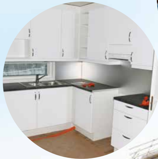
VTS Puukoukku on nyt harjakorkeudessa. Keittiökalusteet olivat paikoillaan jo silloin, kun asunnot tuotiin Kuhmosta Tampereelle.
