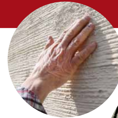
Antinlinnan julkisivurappaus mahdollistaa lähes näkymättömät paikkaukset.
