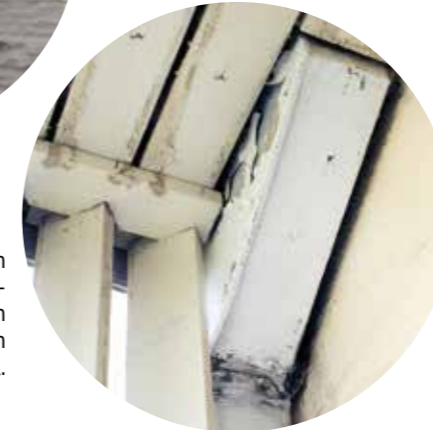
Parvekkeiden vedenpoistojärjestelmä uusitaan saneerauksen yhteydessä.
