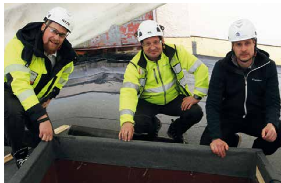
Työnjohtoharjoittelija Erik Lindström (vas.) ja työnjohtaja Jarkko Salminen esittelivät remontin valvojana toimineelle Aki Ojalalle läpivientien ja muiden kriittisten kohtien asennuksia ennen urakan vastaanottoa.
